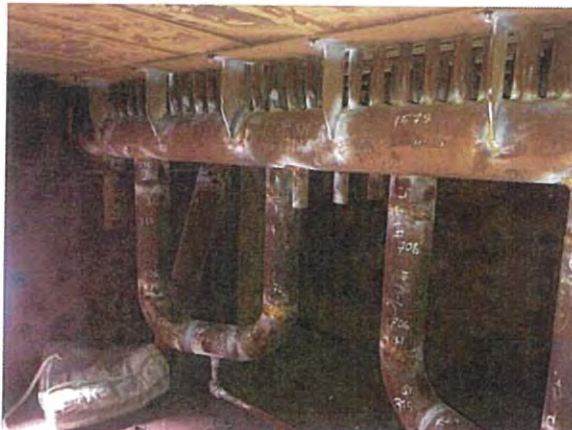
ภาพที่ 8 ภาพถ่ายแสดง การตรวจสอบ สภาพภายในหม้อไอน้ำ ขณะทำการอัดน้ำ Hydrostatic Test เพื่อทำการทดสอบหม้อไอน้ำ
