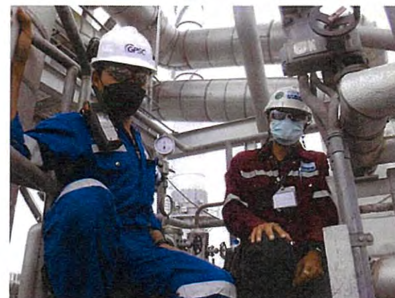
ภาพที่ 6 ภาพถ่ายร่วมกับ ผู้ควบคุมประจำหม้อไอน้ำ ที่ Pressure Gauge ขณะทำการเติมน้ำ Hydrostatic Test เพื่อทำการทดสอบหม้อไอน้ำ
